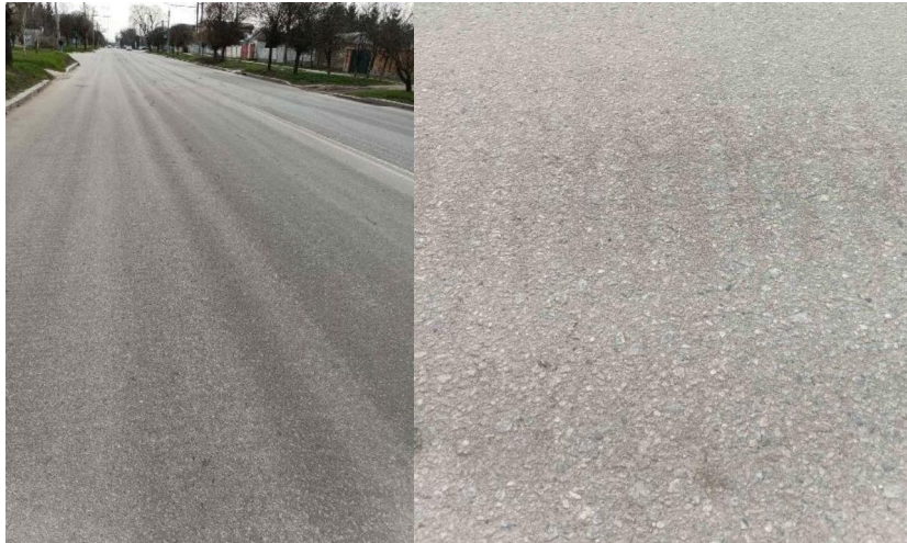
Рис. 1. Загальний вигляд мікропрофілю, що утворився на покритті дороги в результаті проїзду гусеничної військової техніки
